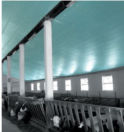
Isolamento térmico FIBRANxps MAESTRO visível a proteger edifício agrícola do sobreaquecimento no verão e arrefecimento no inverno
