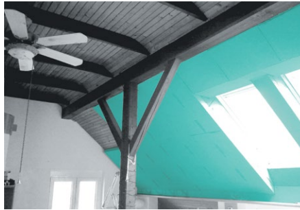
Isolamento térmico pelo interior com FIBRANxps ETICS , superfície revestida com camada fina de argamassa adequada e pintada
