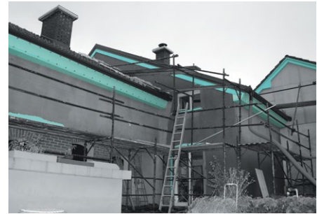
Beirais do telhado revestidos com FIBRANxps ETICS . A espessura depende do vão do telhado.
